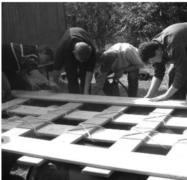
Bauphase, die längs und quer gelegten Bretter werden verknotet und das entstandene Gestell mit den Auftriebskörpern verbunden
