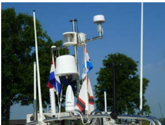
Die Antennen und die Flaggen sind auf dem Dach befestigt und ...
